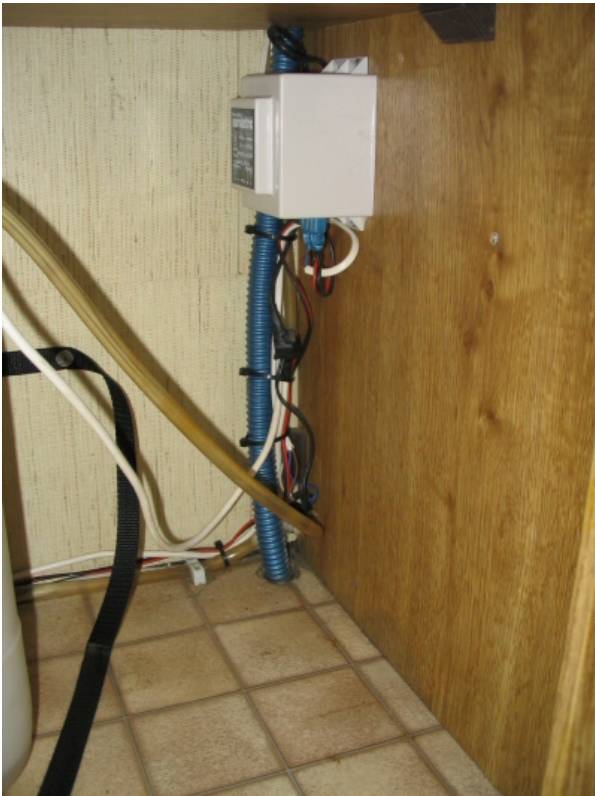
omvormer vanaf de onderkant gezien, in het zwarte ding links zit een glaszekering van 2,5 A.
